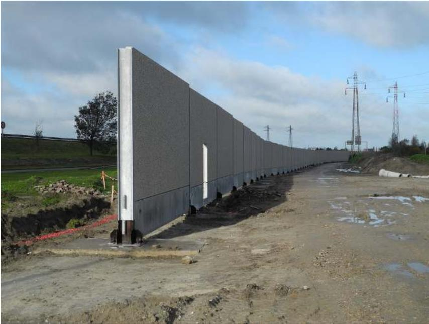
Betonmauer entlang der Zubringerautobahn zum Fährhafen. Der untere Teil befindet sich heute im Boden und verhindert ein Untergraben der Anlage. (Foto: T. Müller, November 2016)
